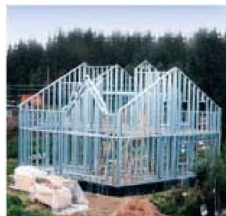
Облегченные стальные каркасы, которые применяются при строительстве «Дома Надежды»
